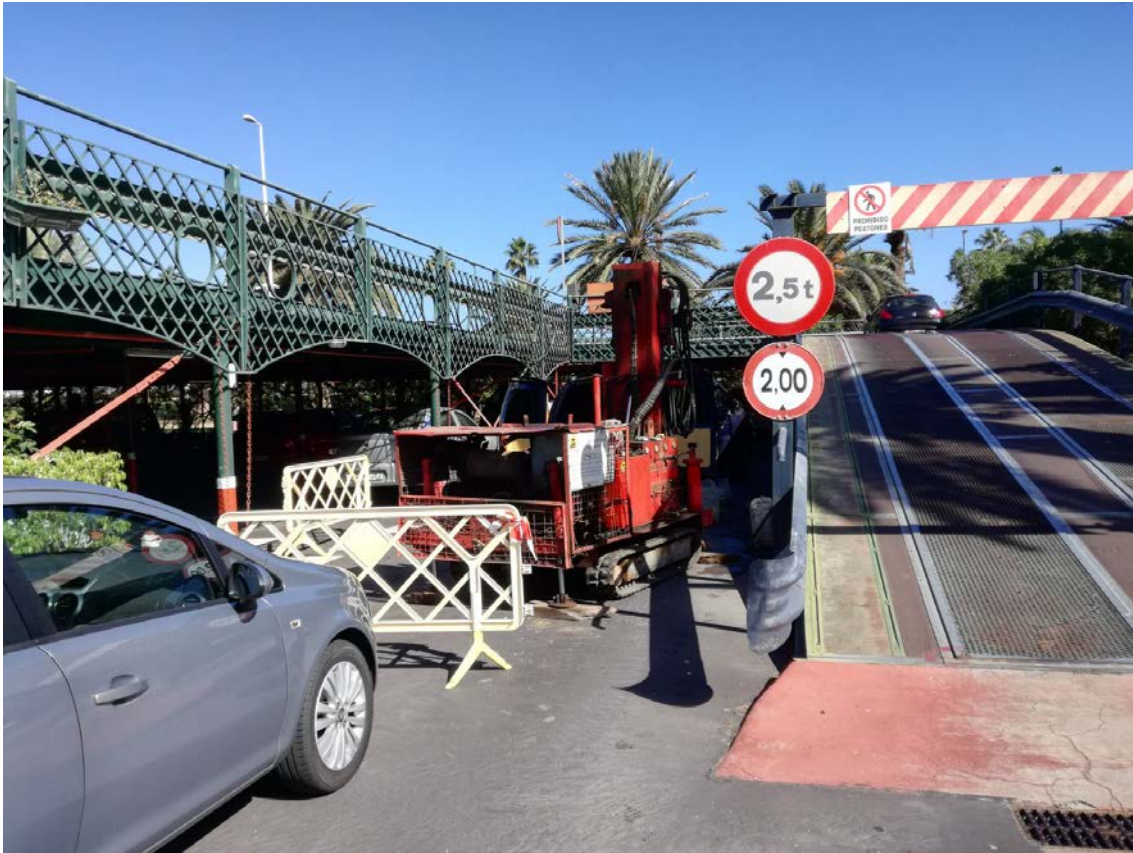
Foto 7: Perforadora Canarias instalada en el sondeo 3
